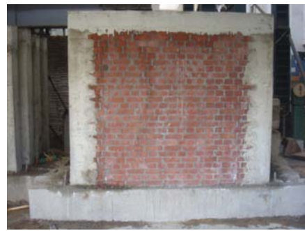
(d) Concrete casting of tie Beam
